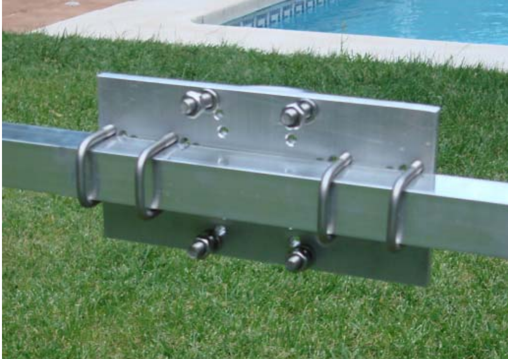
Vista de la placa de unión del boom al mástil
